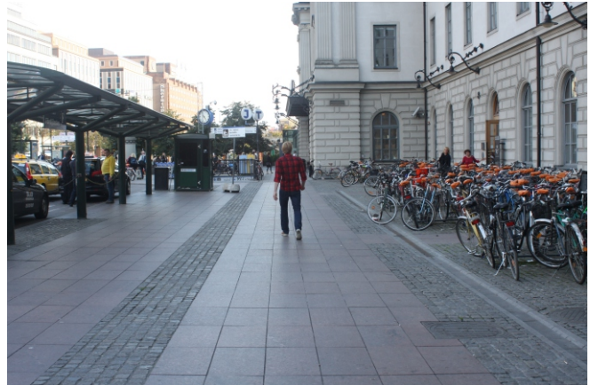
Ryc. 2.3. Faktury nawierzchni chodnika wydzielają strefę ruchu pieszych jako trasę wolną od przeszkód (zdj. M. Wysocki).
