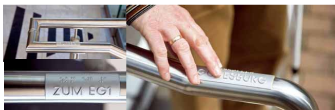
Ryc. 7.11. Oznaczenia na końcach poręczy mogą służyć, jako dodatkowa informacja przy orientacji przestrzennej (źródło: Zeleny 2008, s. 16)
