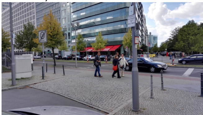
Ryc. 2.7. Przykład wykonania chodnika przejezdnego - Berlin (zdj. R. Lipiński)
