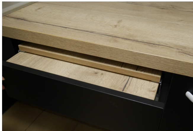
Ryc. 17.3. Przykład adaptabilności w meblach kuchennych, gdzie zamiast szuflady można zamontować wysuwany blat roboczy (zdj. M. Wysocki).
