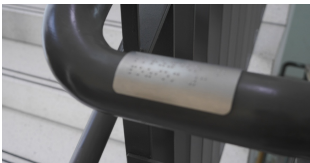
Ryc. 12.11. Informacja w piśmie Braille umieszczona na poręczy. (zdj. M. Wysocki)
