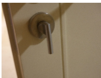
Ryc. 13.6. Zalecane zamknięcie toalety, ułatwiające obsługę przez osobę z ograniczeniami manualnymi (zdj. M. Wysocki).
